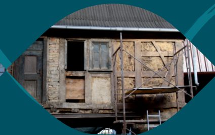
Vorderansicht nach Rückbau 2009
