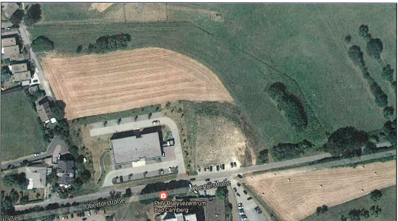
Der Geltungsbereich nördlich der Obertorstraße umfasst die beschriebenen Nutzungskategorien, das Luftbild zeigt die aktuelle Bestandsstruktur
